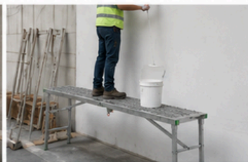
ACCESO PARA PINTURA Y ACABADOS
